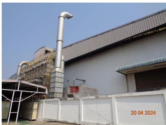
รูปที่ 1 ระบบดักฝุ่นแบบถุงกรองฝุ่น (Bag house Stack)
