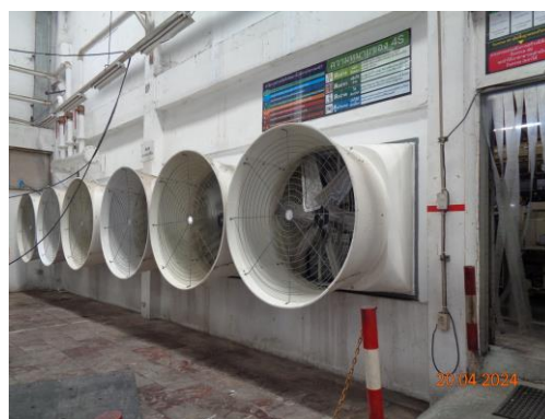
รูปที่ 32 ระบบระบายอากาศในพื้นที่ทำงาน
